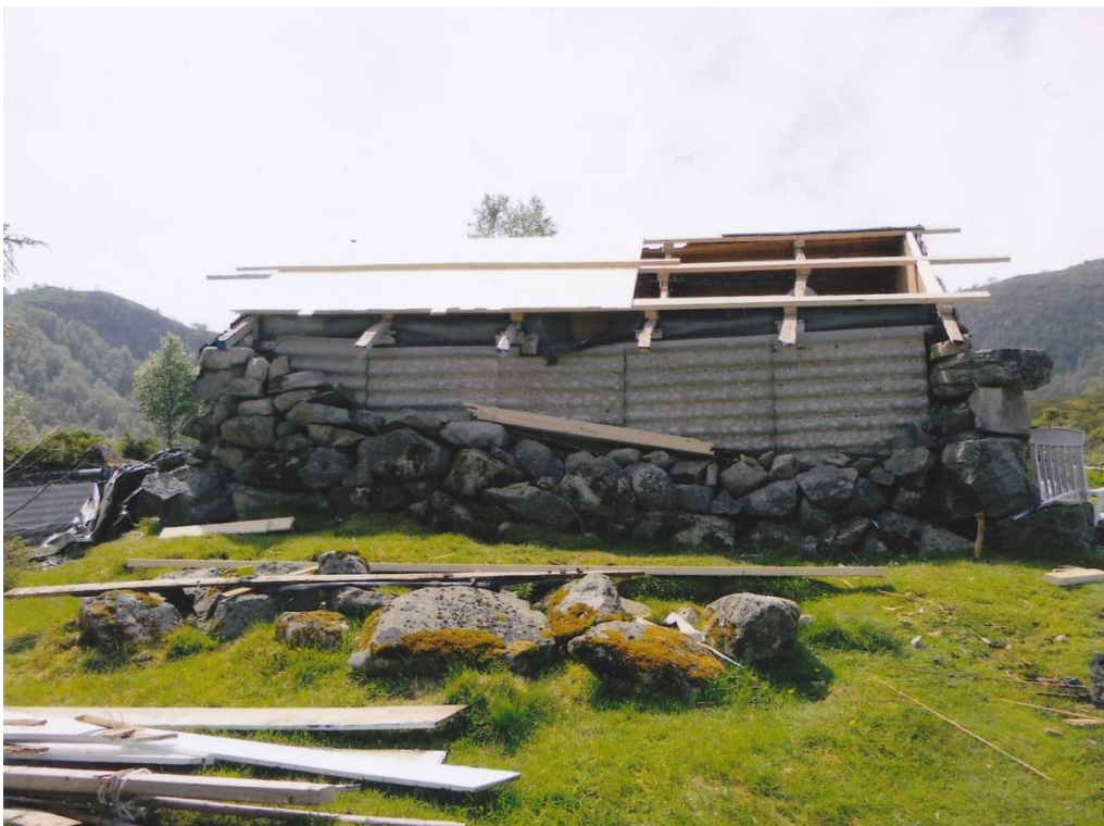
Taket måtte byttes. Dette hastet aller mest fordi det var råttent. 25 år var gått siden noe ordentlig vedlikehold hadde blitt utført på Fjellhytta, «Klobben». Den steinsatte muren som før nådde til taket er rast ut og trenger reparasjon.
