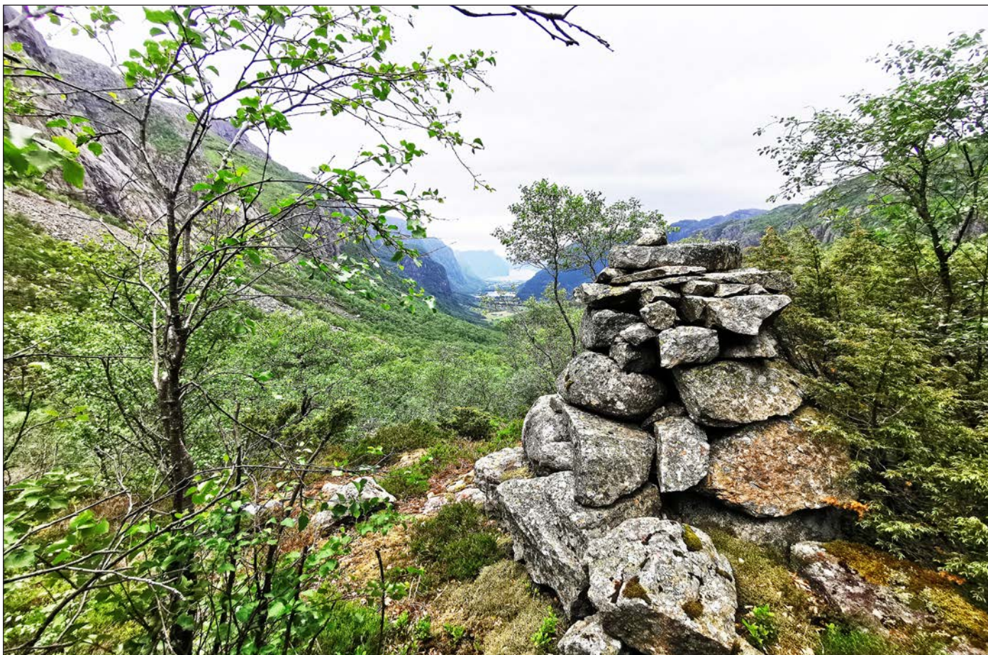
Dette oppmurte løypestrengtårnet er plassert på eit lite berg for å få god høgde ut. I bakgrunnen Molaugvatnet og fjorden.
