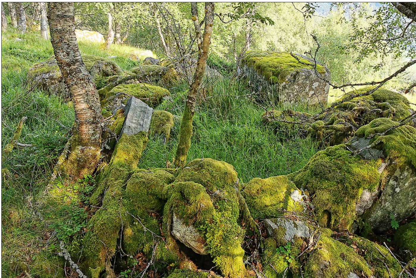
Bygning 1. Grov stein er nytta for å laga ein grunnmur i dette stols huset. Svært mosegrodd nå.
